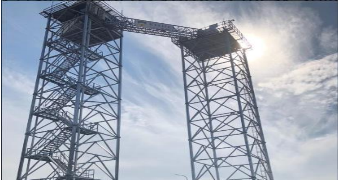
Şekil 8: Alçak Seviye Rüzgâr Kırılımı Uyarı Sistemi - Low Level Wind Shear Alert System (LLWAS)
